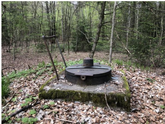
2,4 km alter Hochbehälter
